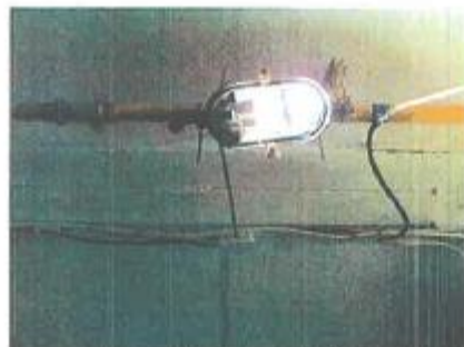
8 pav. Bendro naudojimo patalpose netvarkinga elektros instaliacija.
