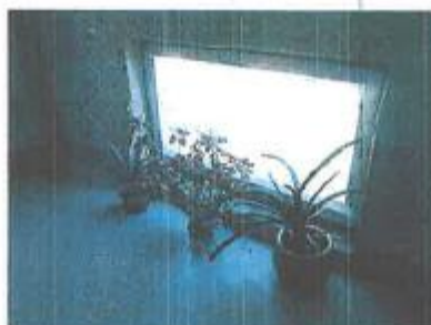
10 pav. Laiptinėje prie dalies langų nėra apsauginių tvorelių.
