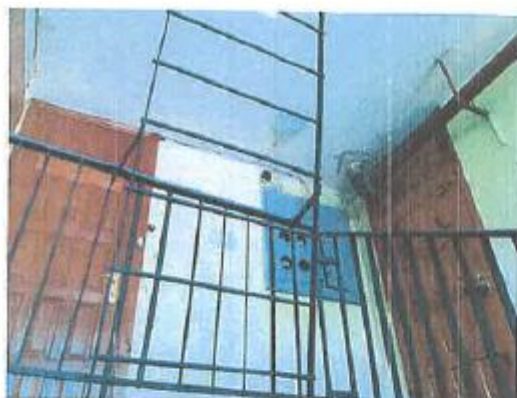
11 pav. Patekimas kopėčiomis ant stogo nesaugus. Pastate senos, nusidėvėjusios bendrų patalpų vidaus inžinerinės sistemos.
