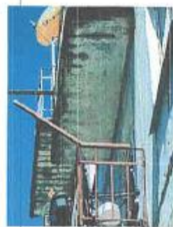
7 pav. Pažeistas balkonų g/b plokščių apsauginis sluoksnis, matosi koroduojanti armatūra. Kai kuriems butų balkonams trūksta dalies aptvarų.
