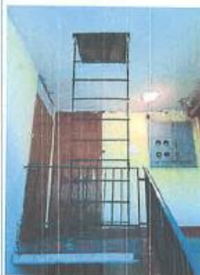
11 pav. Patekimas kopėčiomis ant stogo nesaugus. Pastate senos, nusidėvėjusios bendrų patalpų vidaus inžinerinės sistemos.
