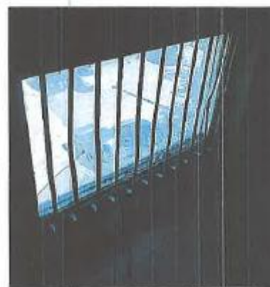
6 pav. Nusidėvėję, seni nesandarūs bendro naudojimo patalpų langai, kai kurių stiklai pažeisti.
