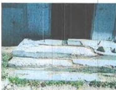
9 pav. Netvarkinga, nelygi išorinių laiptų aikštelės ir pakopų danga.
