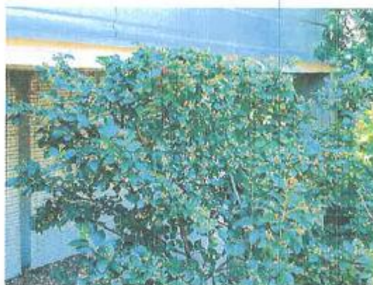
2 pav. Prie pastato vietomis nėra nuogrindų. Prie pastato augantys krūmai ir kiti augalai, ardo pamatus, gadina fasadą.
