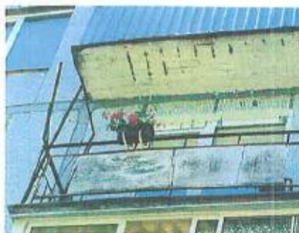
7 pav. Pažeistas balkonų g/b plokščių apsauginis sluoksnis, matosi koroduojanti armatūra. Kai kuriems butų balkonams trūksta dalies aptvarų.
