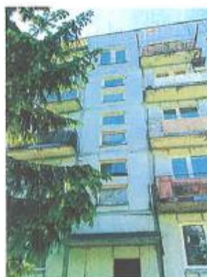
6 pav. Nusidėvėję, seni nesandarūs bendro naudojimo patalpų langai, kai kurių stiklai pažeisti.
